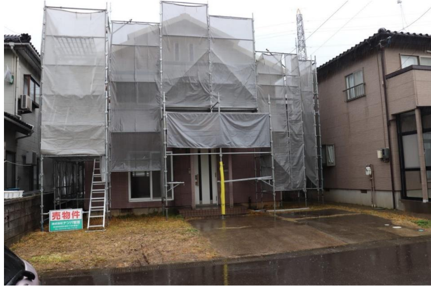
●外壁張替え、玄関ドア交換を行います！
